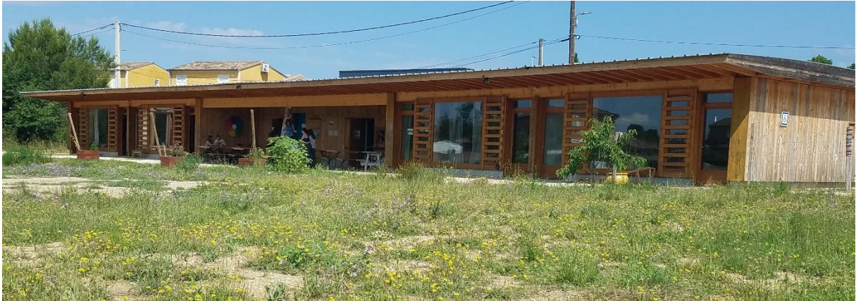
(Vue de face du collège mitoyen des terres de la ferme)
